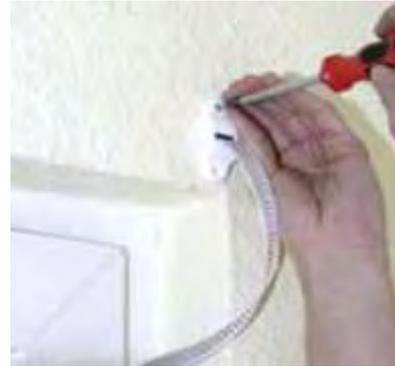
6. Die Aufreibblasen ausziehen und mit Fensterrahmen vom Schraubendreher eine Seite des Gehäuses abhebend- den Wickler öffnen. Den Wickler zum Fensterrahme mit den Bolzen anschrauben. Die Gurt auf dem Haken anhaken und dabei die Federdose kräftig haltend umdrehen und die Blockade befreien. Beim montierten Wickler und dem heruntergelassenen Panzer muss man auf den Federtrommel 2-3 Gurtwicklungen wickeln. Das Panzergehäuse schließen.
